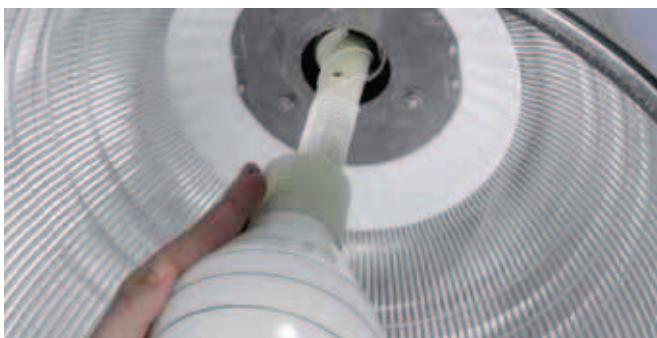
Induktionsleuchtmittel, Energieübertragung ohne elektrische Verbindung.
